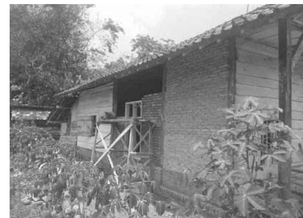
Rumah Madyo sedang dalam proses pembangunan
